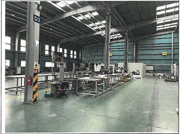
본건 건물 내부촬영
